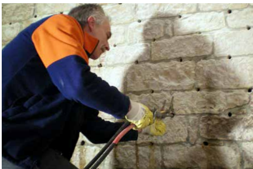
2. Einbringung des DRYflex-Hydrogels über das Drytech-Bohrraster.
