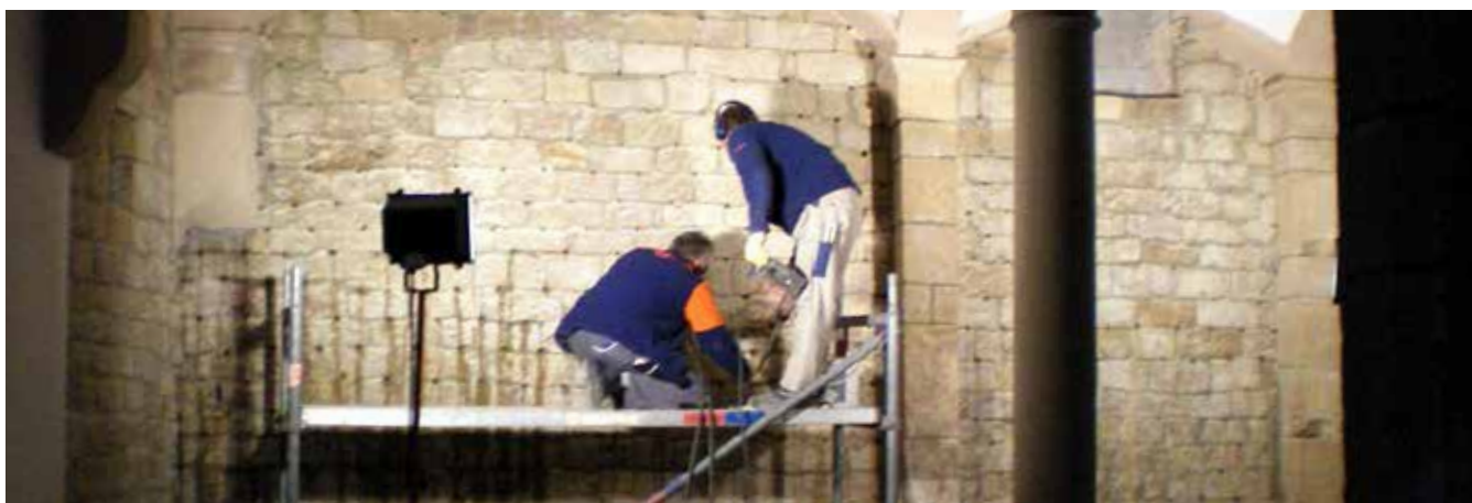
1. Drytech-Mitarbeiter bei der Sanierung der Natursteinwand.
