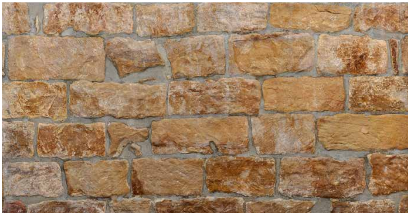
5. Detailansicht der Natursteinwand im Leopold Restaurant in ihrem heutigen Zustand.
