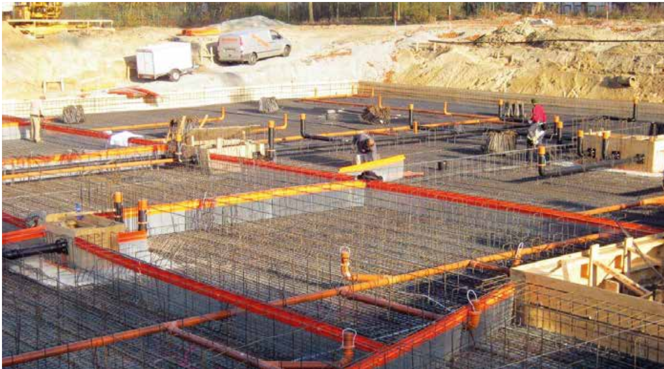
Verlegte DRYset-Sollrissprofile in der Bodenplatte: Ist der Beton ausgehärtet, werden die gemäß dem Bewehrungsplan erzeugten Bauteilfugen über die Verpressung des Acrylatgels DRYflex vollflächig geschlossen.
