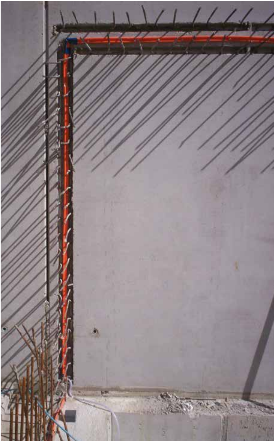
In der Wand verlegte DRYset-Injektionsprofile: Die DRYset-Komponenten verfügen über ein Allgemeines bauaufsichtliches Prüfzeugnis der MFPA Leipzig GmbH (Prüf-, Überwachungs- und Zertifizierungsstelle für Baustoffe, Bauprodukte und Bausysteme).
