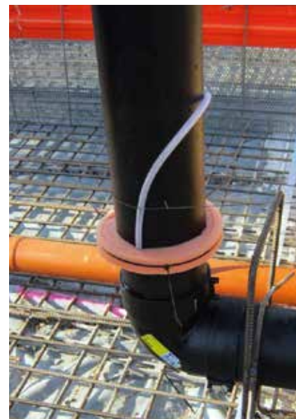
Einfachste Montage für die Abdichtung von Rohrdurchdringungen bei einer Weißen Wanne System Drytech.
