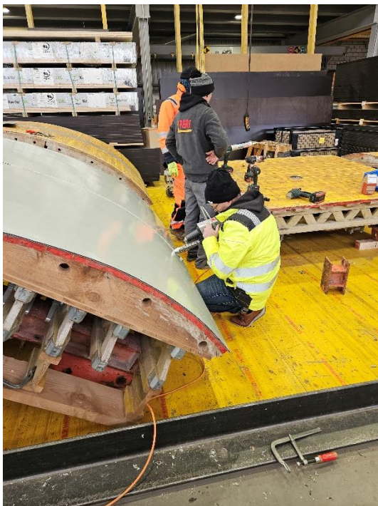
Verschweissen der alkus® GM6 Schalungsplatten auf der PERI-Stollenschalung. | © alkus AG
